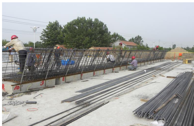
钢筋胎架绑扎
