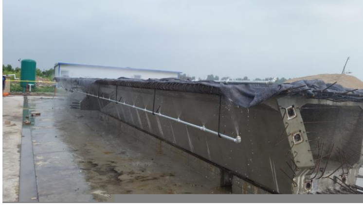
箱梁喷淋养生照片
