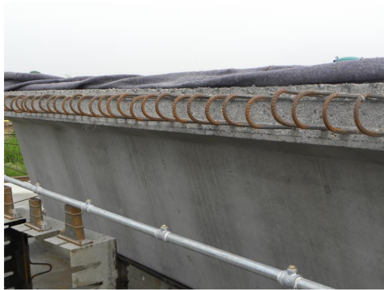
接缝和接头处凿毛
