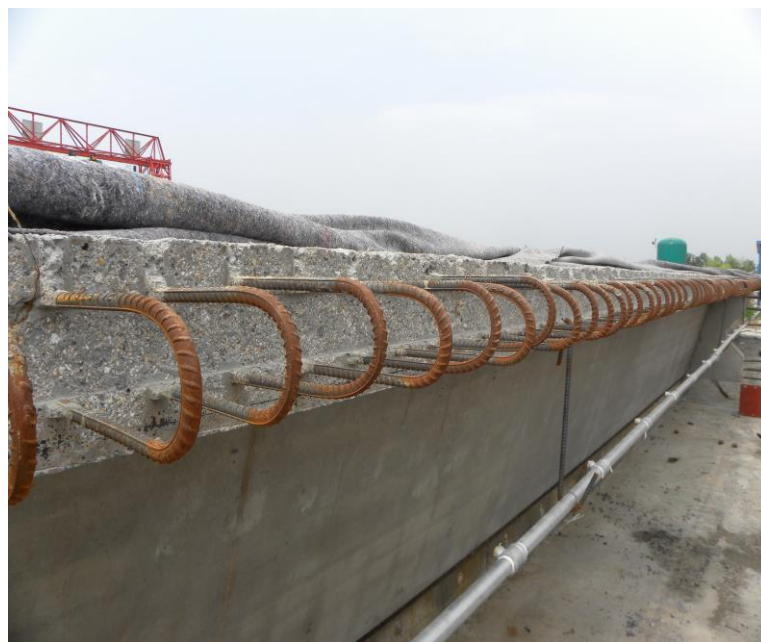
接缝和接头处凿毛
